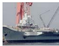
瓦良格号舰桥拆卸脚手架
