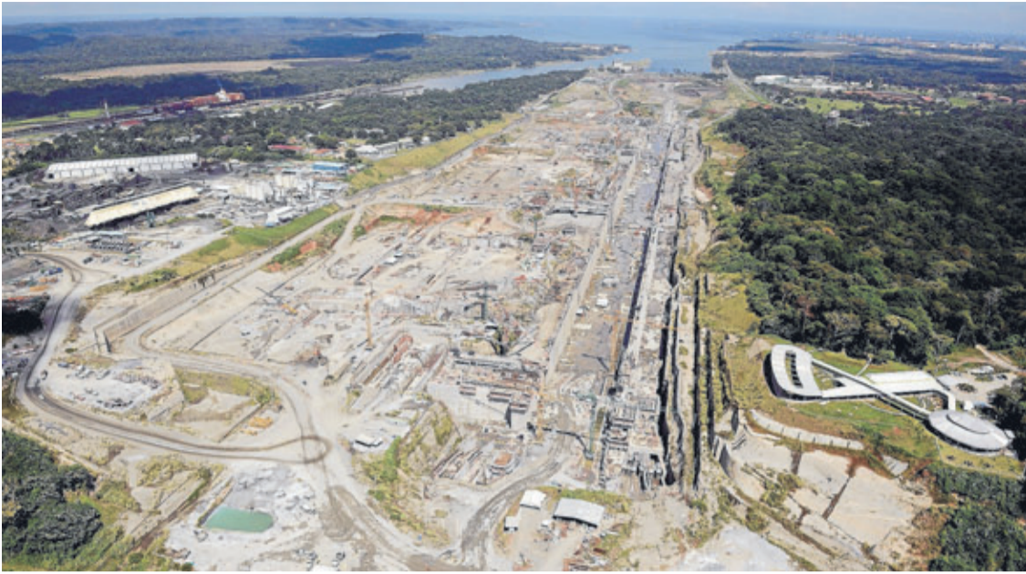
El conflicto entre el gobierno y el grupo constructor tuvo paralizada la obra. FOTOS CORTESÍA DEL CANAL DE PANAMÁ
